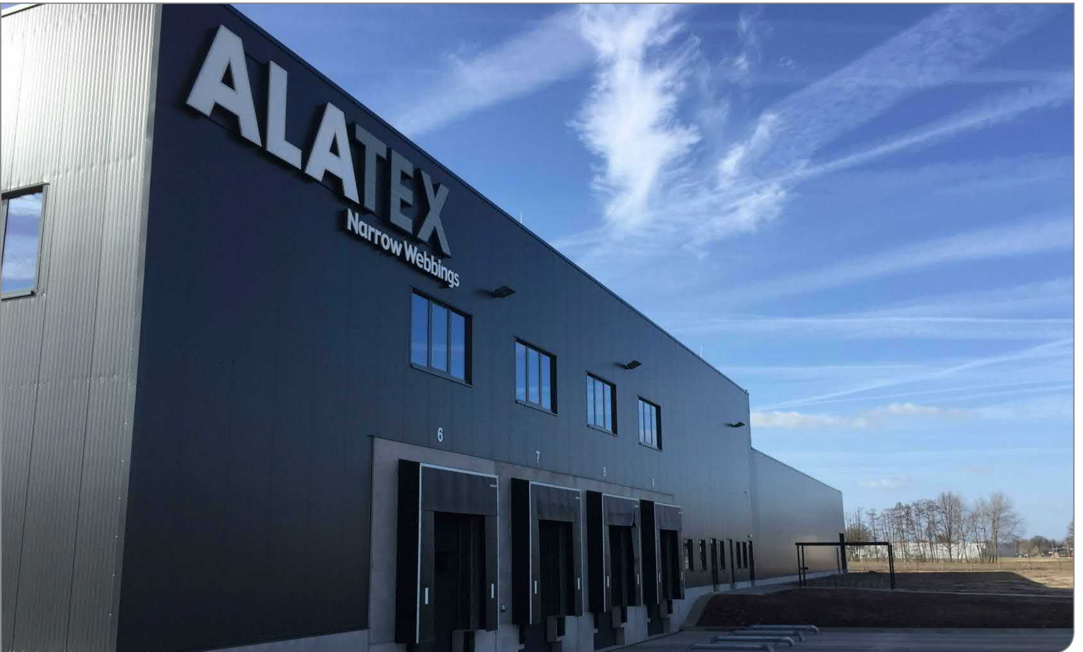
Betriebserweiterung durch Anbau einer Produktions- und Lagerhalle in Emsdetten / gebaut
