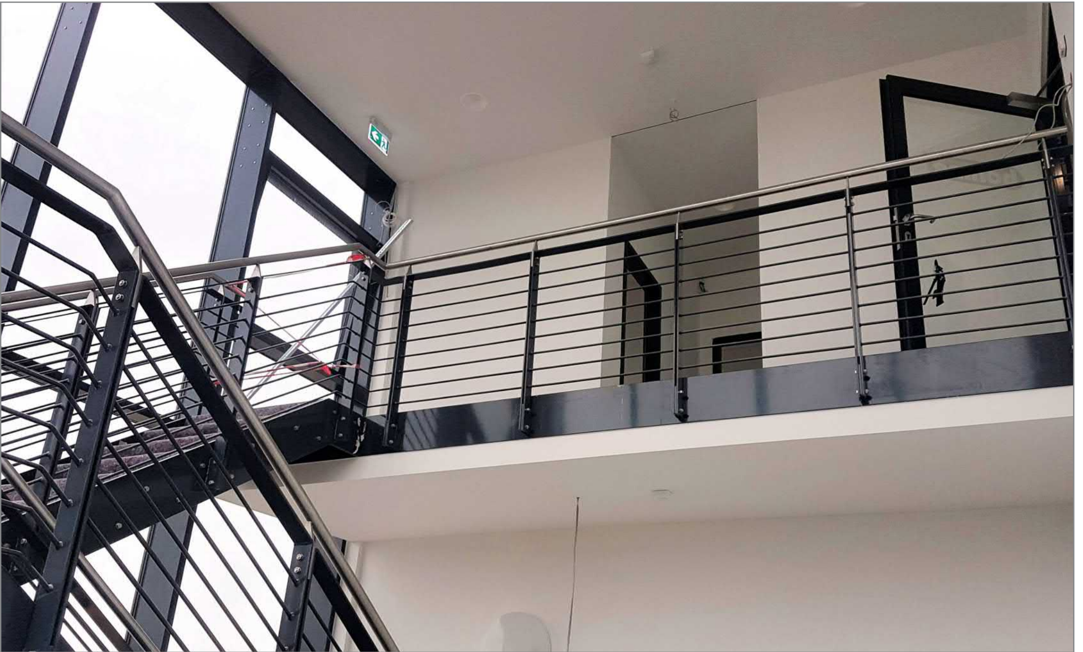
Neubau eines Betriebsgebäudes in Büchen / gebaut
