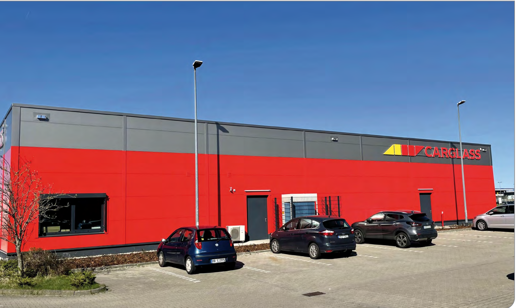
Neubau Servicecenter Carglass / gebaut
