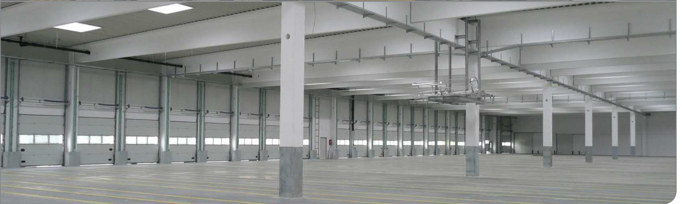
Erweiterung einer Umschlaghalle in Bad Salzuflen / gebaut
