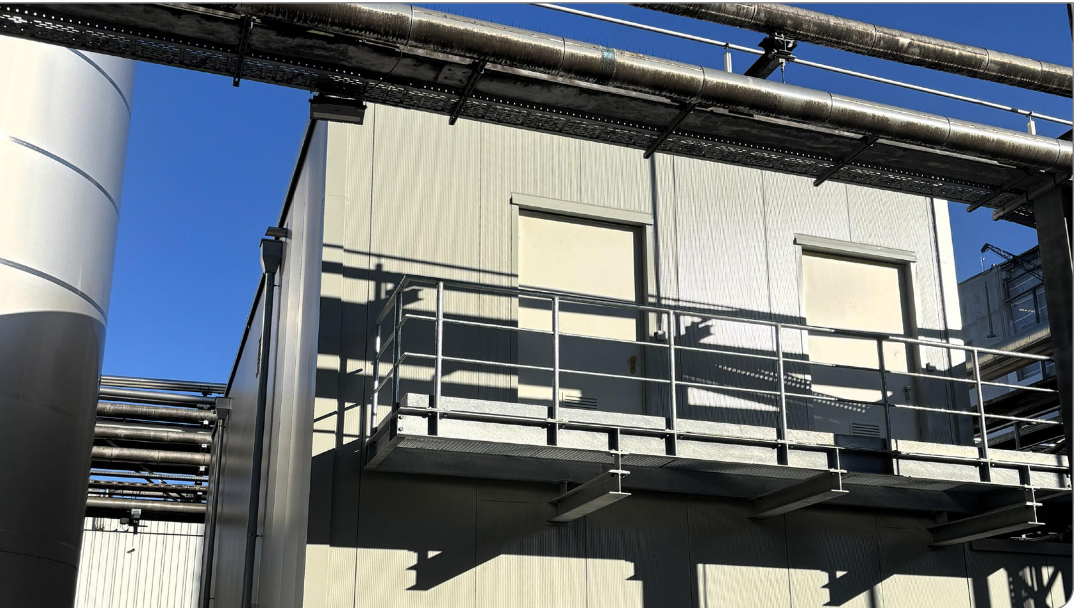
Neubau eines Mittelspannungsgebäudes in Hamburg-Wandsbek / gebaut
