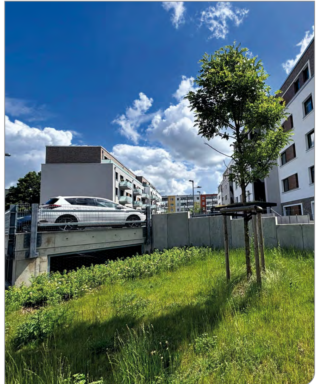
Neubau eines Parkdecks für zwei Mehrfamilienhäuser / gebaut
