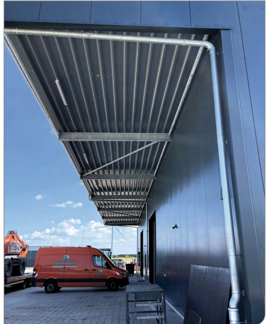
Neubau eines Betriebsstandortes 1. Bauabschnitt, die Halle / gebaut
