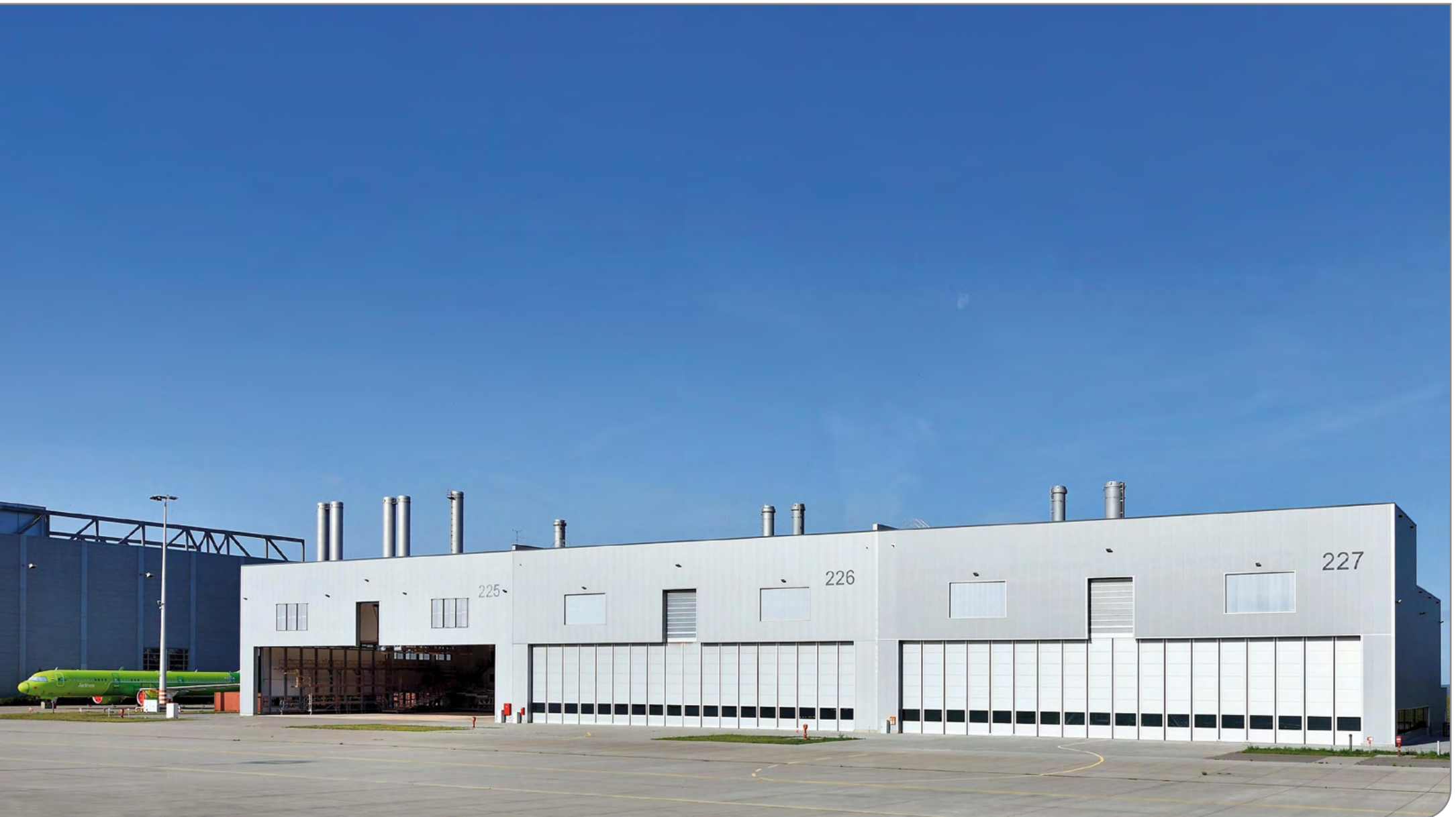
Drei Flugzeuglackierhallen für MAAS Aviation auf dem Airbusgelände / gebaut
