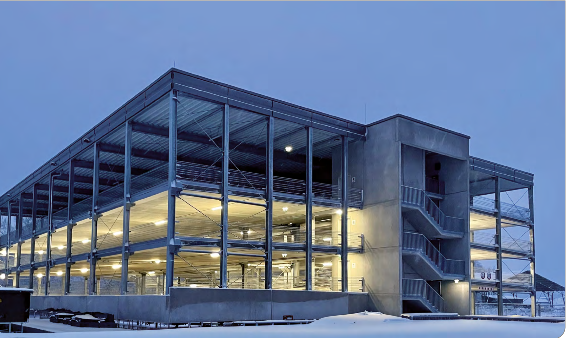
Neubau einer offenen Quartiersgarage / gebaut
