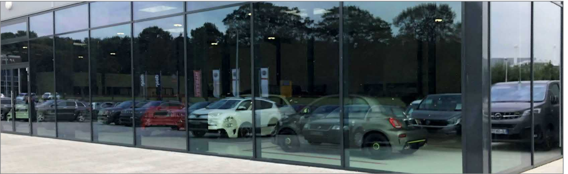
Ein sonniger Gesamtblick auf die Fassade aus PR-Elementen und Isopaneelen.
